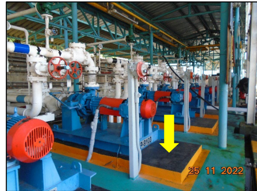
ภาพที่ 2-3 คันคอนกรีต (Bund Wall) ล้อมรอบปั๊มและคอมเพรสเซอร์
