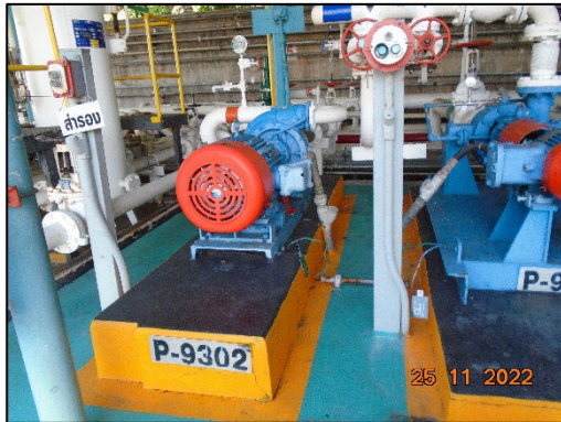
ภาพที่ 2-3 คันคอนกรีต (Bund Wall) ล้อมรอบปั๊มและคอมเพรสเซอร์
